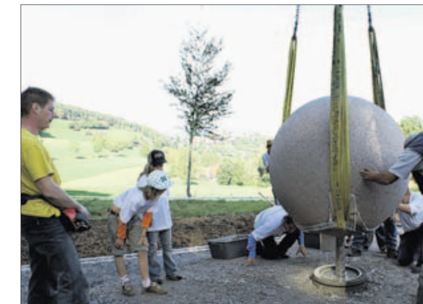
Luft anhalten und Augen auf: Die 4,1 Tonnen schwere Sonne mit Chromstahldorn muss millimetergenau abgesetzt werden. (nanu)
